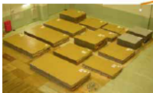
真空容器材料納入
